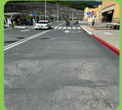
Rehabilitación de Carpeta
