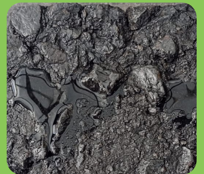
Sellado profundo de la carpeta asfáltica
