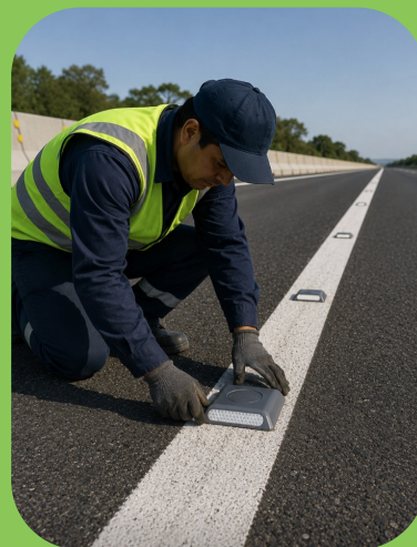
Carreteras de Asfalto
