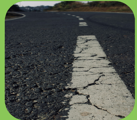
Carreteras de Asfalto
