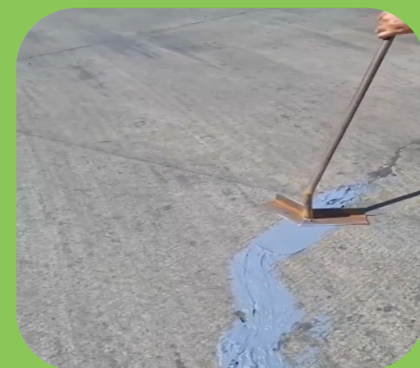
Aeropuertos/Patios de Maniobras
